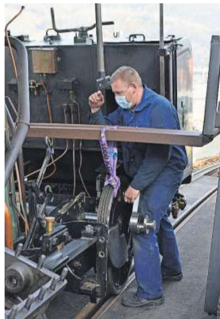
Die 600 Kilogramm schwere Kurbelwelle wird in der Lok eingesetzt.
