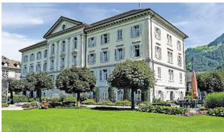
Bereits im kommenden Jahr fahren die Baumaschinen auf: Dann wird aus dem denkmalgeschützten Haus Hofmatt ein Generationenprojekt. Bild: Erhard Gick
