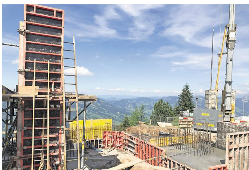
Gut ersichtlich ist in der Bergstation Rigi Scheidegg auf dem rechten Bildrand die Schalung für den ersten von mehreren Betonstehern, welche dereinst den Antrieb der Bahn tragen werden.
