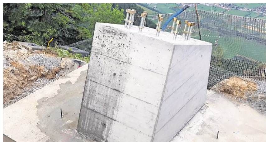
... von welchem nach dem Einbetonieren nicht mehr viel zu sehen ist. An diesen Schrauben werden später die Rohrstützen befestigt. Bilder: Rita Baggenstos
