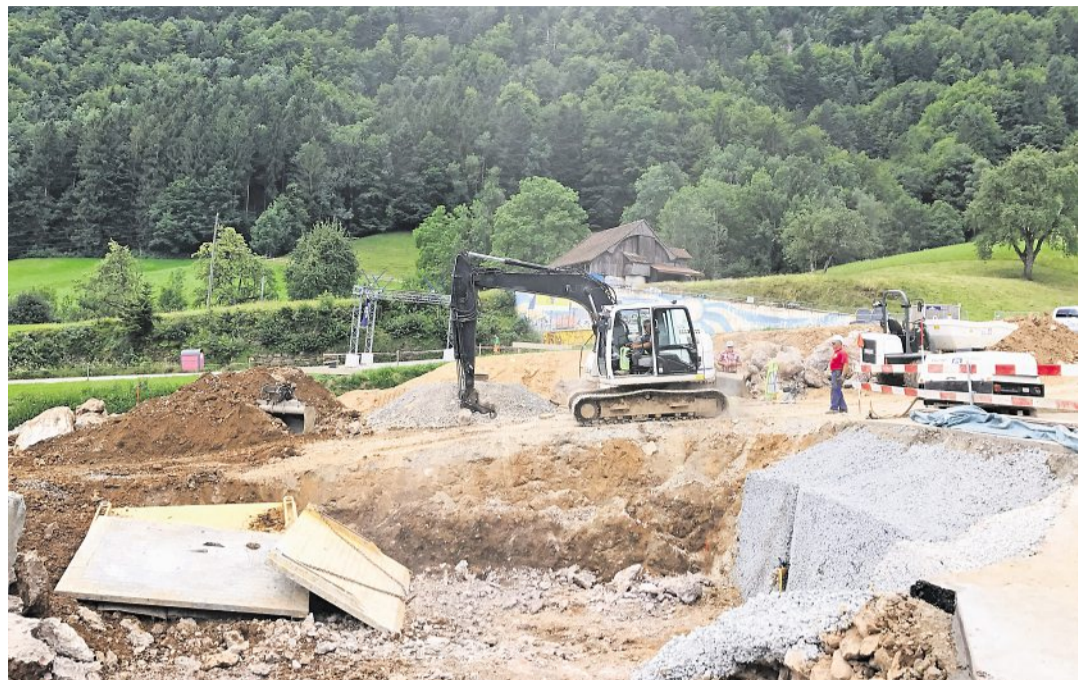
Die alte Talstation der Luftseilbahn Kräbel-Rigi Scheidegg ist soweit erforderlich abtransportiert worden. Diese Baustelle von insgesamt vier ist am wenigsten wetterabhängig und konnte daher als letzte in Angriff genommen werden; jedoch auch hier wird mit Hochdruck gearbeitet.
