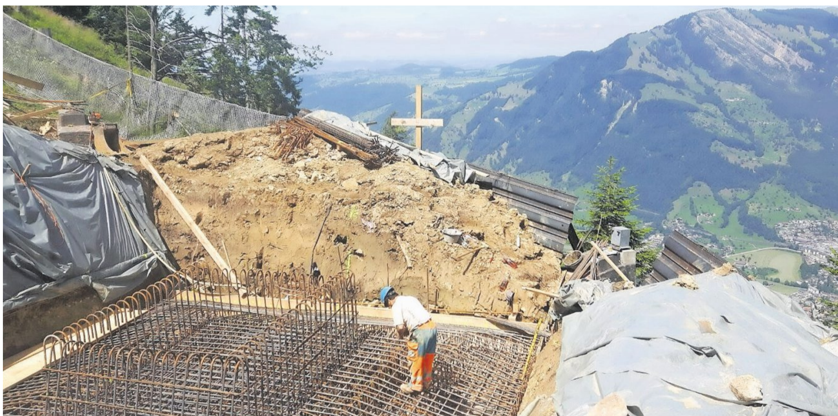
Arbeitsplatz mit herrlicher Aussicht: Bei der Stütze 2 sind die Armierungen eingebracht, und die Firma Swiss Helikopter wird tonnenweise Beton zur Stütze fliegen.
