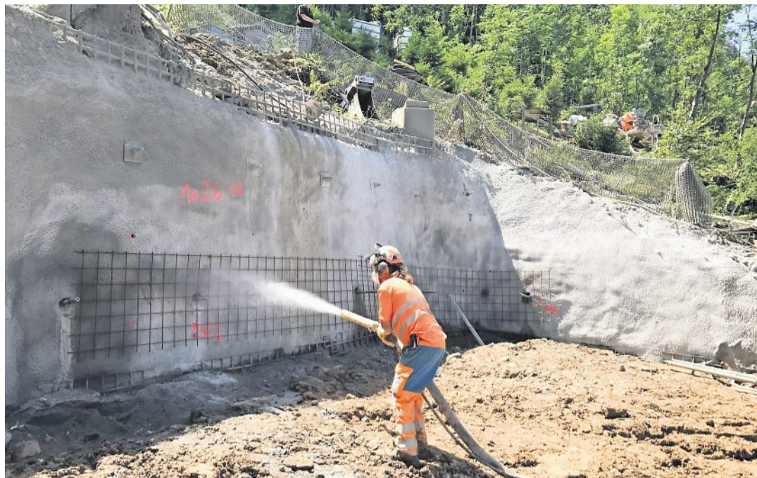
Bei Stütze 1 muss der Hang bergwärts mit Felsankern gesichert und mit Spritzbeton verfestigt werden. An dieser Baustelle erwies sich die Wasserbeschaffung für den Spritzbeton als kleines Problem, da das Wasser zum Teil hochgeflogen werden musste.
